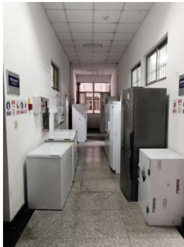
逸夫楼 2046 室旁边楼道内设备阻挡消防通道
