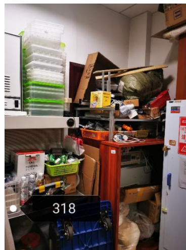
食品楼 318-实验室消防通道门被堵
