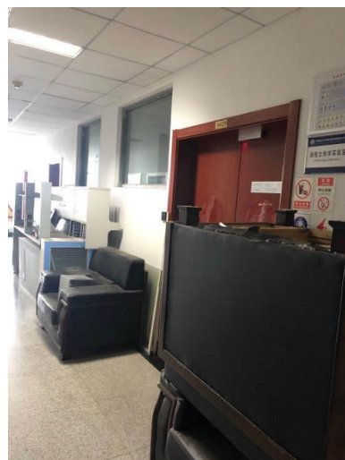
理科楼 6 楼家具等阻挡消防通道
