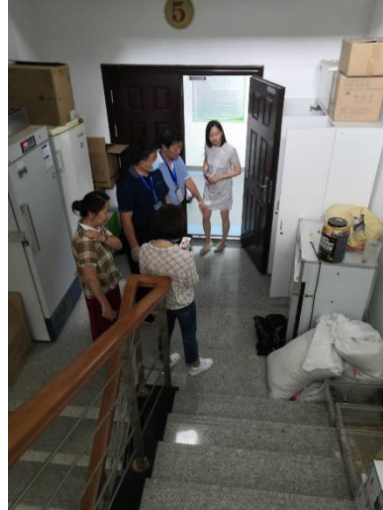
逸夫楼 5 楼楼梯出口物品摆放阻挡消防通道
