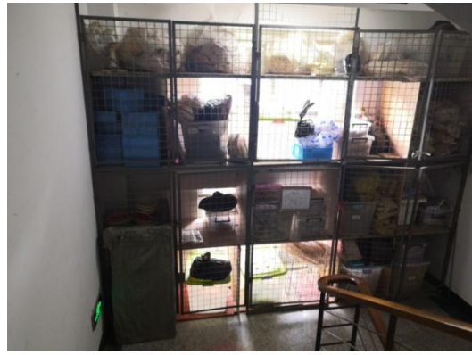
生科楼 2 楼到 3 楼间 B 座西侧楼梯口 堆放大量杂物
