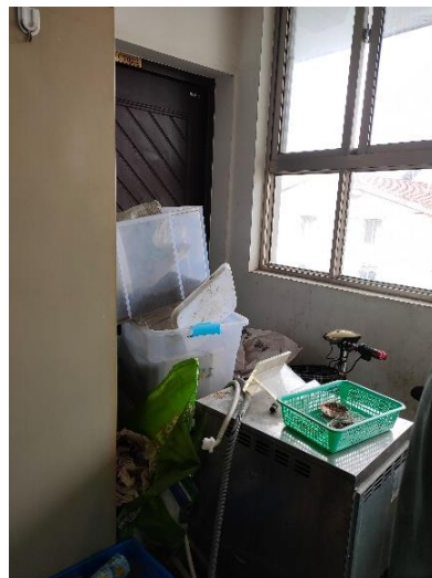
生科楼 C7021—实验室消防通道门被堵
