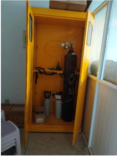
生科楼公共实验室 C6010—气体钢瓶未固定，已经 2 次告知整改，但仍未整改
