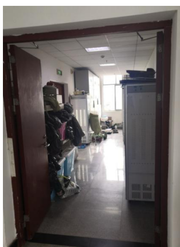
理科楼 6 楼 A 座东楼梯口安全通道附近堆放太多东西
