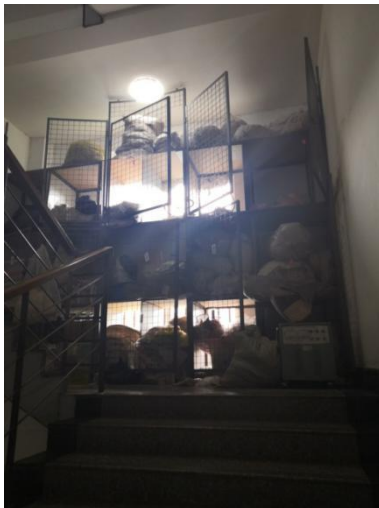
生科楼 3 楼到 4 楼之间 B 座西侧楼梯口 堆放大量杂物
