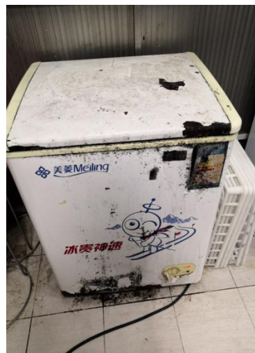
生科楼负 B1021—电线很多，接线板直接放置地面使用，门口滴水，地面潮湿；冰柜腐蚀且漏水， 负责人徐志刚
