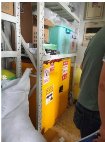
生科楼 C6016 实验室后门被危化品柜堵住
