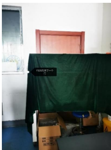
理科南楼 F325—实验室消防通道门被堵
