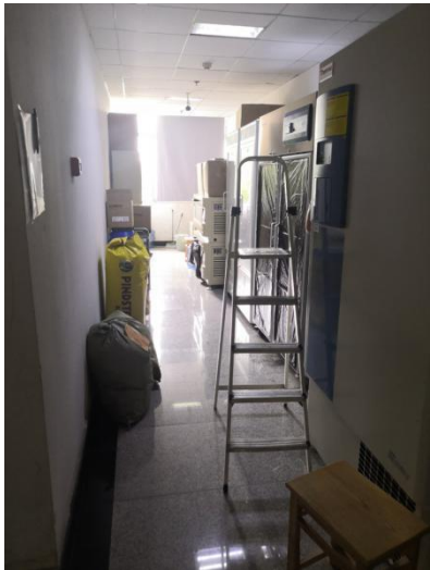
理科楼 B204—实验室门外堆放过多物品， 堆放实验室废弃物
