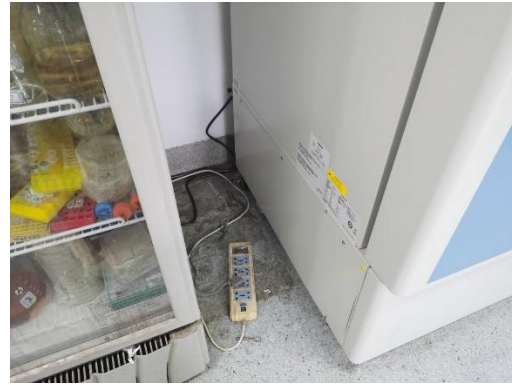
理科楼 A321—接线板直接置于地面使用，未固定。负责人曹爱忠（左边初查，右边复查）
