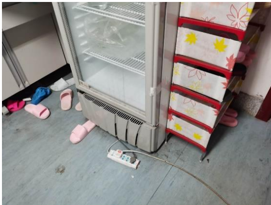
理科南楼 F511—接线板放置地面使用。负责人杨守萍（左边初查，右边复查）
