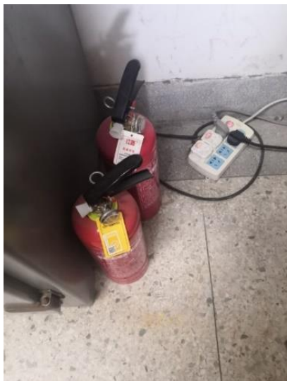
理科楼 B706—接线板放置于地面使用。负责人郭坚华（左边初查，右边复查）
