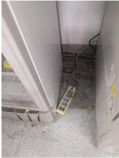
理科楼 A321—接线板直接置于地面使用，未固定。负责人曹爱忠（左边初查，右边复查）
