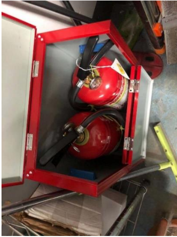
资环楼 A223—灭火器缺点检记录卡；实验室杂乱；通风橱里杂物堆放。
