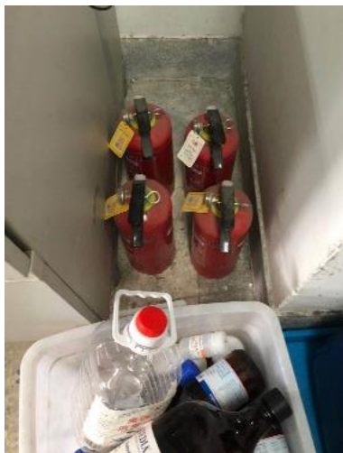
理科楼 B601—灭火器无架子和点检记录卡，液氮罐未配备防冻手套；负责人高学文
