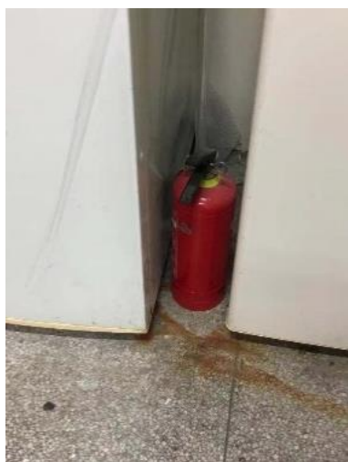
食品楼 A415—灭火器没有架子和点检记录卡；烘箱没有使用登记表 负责人曾晓雄
