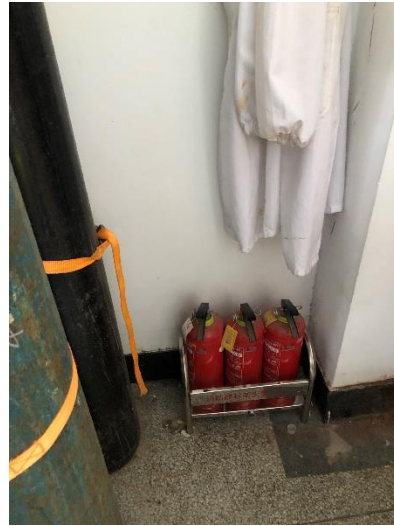
化学楼 422-配电箱被遮挡, 灭火器无点检记录卡, 负责人朱映光
