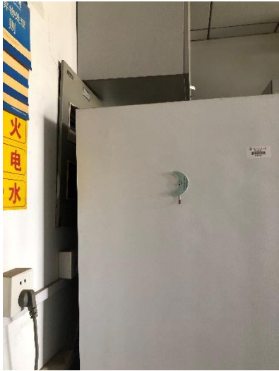
化学楼 422-配电箱被遮挡, 灭火器无点检记录卡, 负责人朱映光
