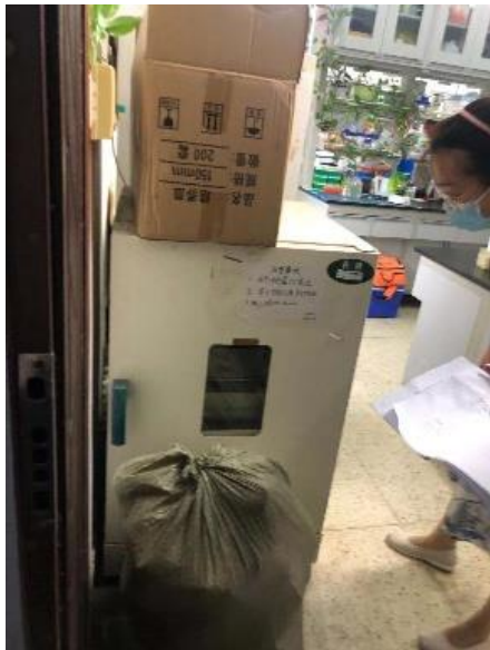
生科楼 C4013—配电箱被档；烘箱缺操作规程，周围有易燃杂物。负责人腊红桂
