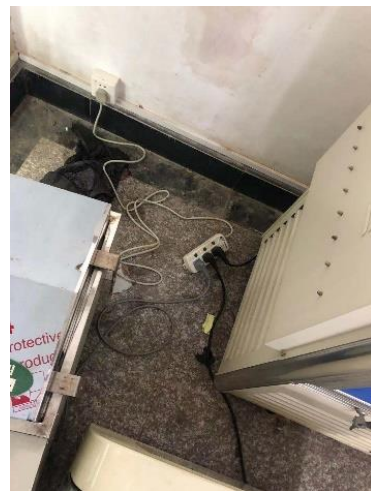
生科楼六楼 C 座通 B 座连廊—放在公共区域的摇床接线板使用不规范，直接放置于地面使用，且靠近窗户，有淋雨的隐患。负责人钟镇涛
