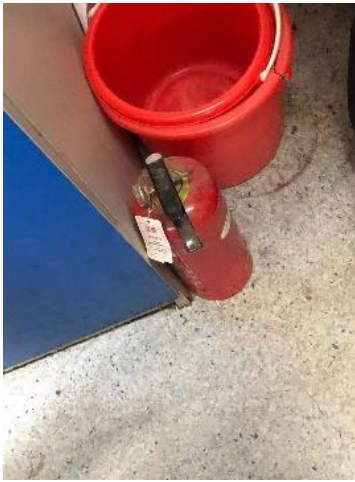
生科楼 B4019—液氮罐未配备防冻手套；灭火器无架子和点检记录卡。负责人徐迎春
