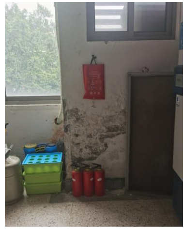
理科楼 A409-411—灭火器未配备架子，无点检记录卡 负责人蔡彩平
