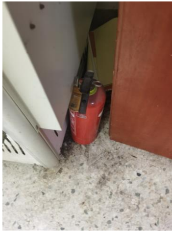
理科楼 A409-411—灭火器未配备架子，无点检记录卡 负责人蔡彩平
