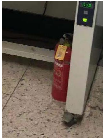
生科楼 B4019—液氮罐未配备防冻手套；灭火器无架子和点检记录卡。负责人徐迎春
