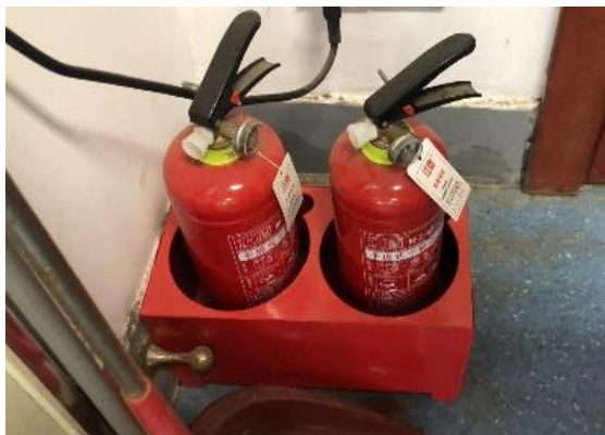
理科南楼 F325—灭火器没有点检记录卡；实验室同学不会用洗眼器，安全教育不到位。 负责人郭振飞
