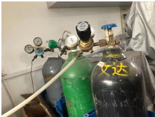
逸夫楼 4004—实验室危化品目录上有剧毒试剂（金属汞）、易制爆试剂（苦味酸），账物不符； 废弃物收集区未张贴警示带，气瓶无状态标识。 负责人沈向真
