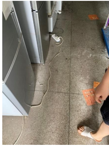
教十楼 5 楼西南侧楼道—多个插座串联使用 负责人董明盛
