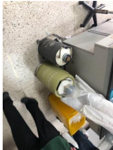
理科楼 B601—灭火器无架子和点检记录卡，液氮罐未配备防冻手套；负责人高学文
