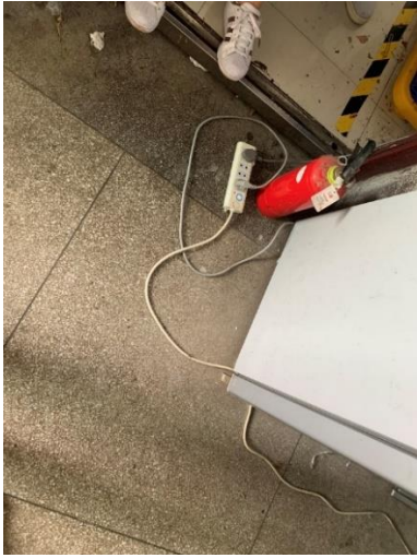
教十楼 5 楼西南侧楼道—多个插座串联使用 负责人董明盛
