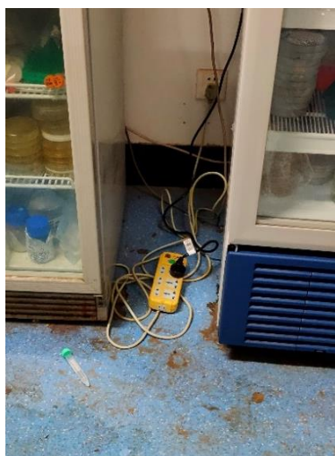
生科楼 B2015—接线板放置地面使用，且地面有水；危化品柜未锁 负责人鲍依群
