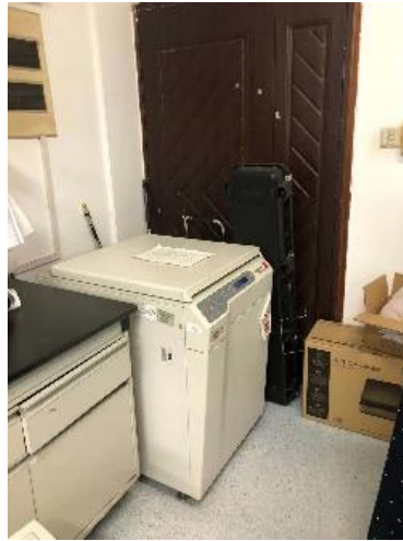
生科楼 B206—设备堵塞消防通道 负责人周治国
