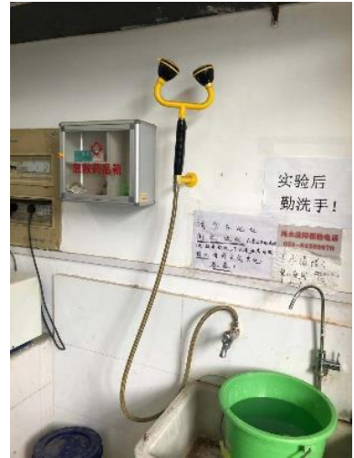
逸夫楼 2020—废弃物收集区未张贴警示标识和警示带；洗眼器不出水，下水不通；气瓶没有状态标识。 负责人余祖功
