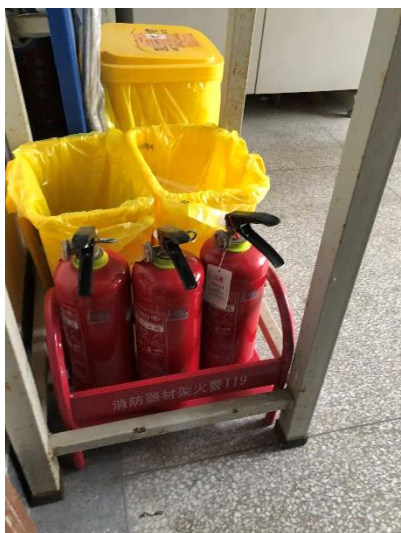
化学楼 415-灭火器无点检记录卡，气瓶使用状态错误，实际不在用，状态标签是“使用中”，负责人朱映光
